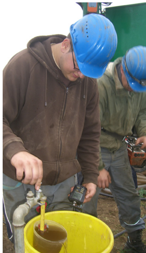
Bild 2: Laufende Prozesskontrolle während der Regenerierarbeiten © Rudolf Lange Brunnenbau KG, 2013
