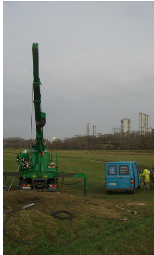
Bild 1: Baustelle an der Flussseite © Rudolf Lange Brunnenbau KG, 2013
